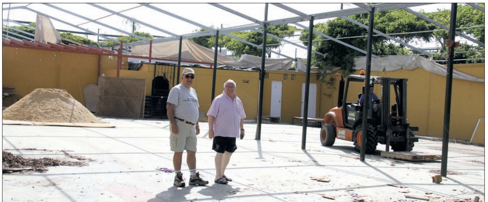
Manuel Curtido y Miguel Carmona supervisan el comienzo de los trabajos.
