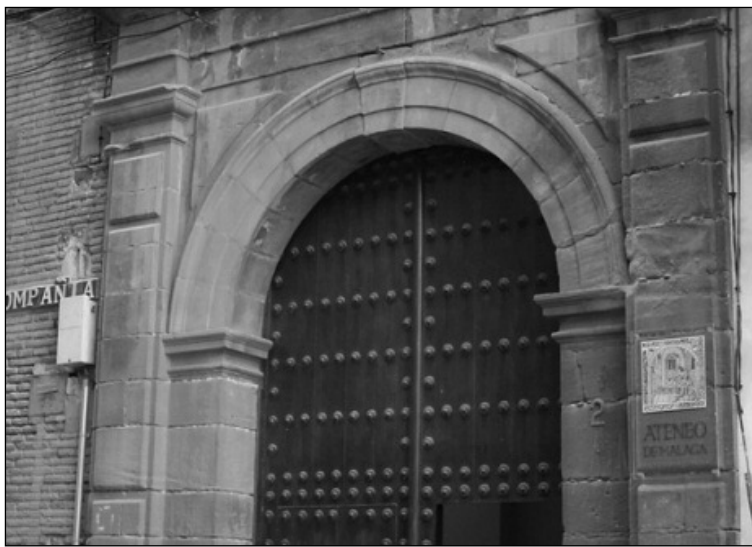
Fachada del edificio del Ateneo.
