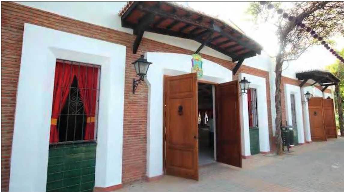
Caseta peñista en el recinto ferial de Cortijo de Torres.
