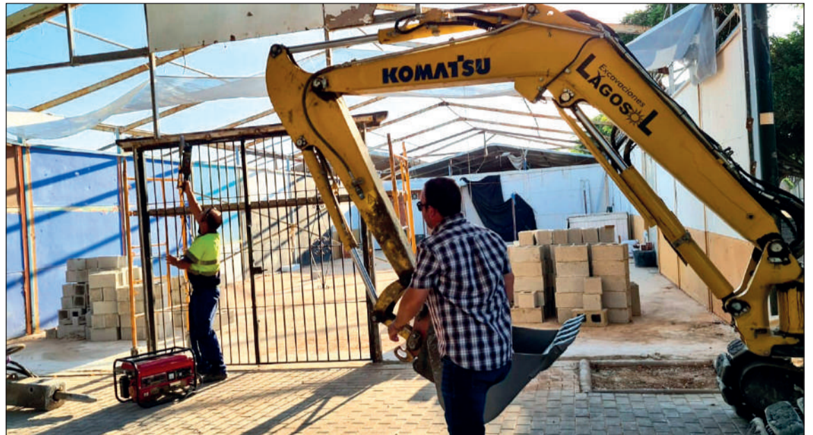
Son numerosas las casetas, como esta de Los Mimbrales, que están acometiendo obras importantes.
