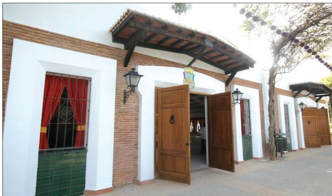
La caseta de la Federación está recuperando su estado original a instancias del Instituto Municipal de la Vivienda.
