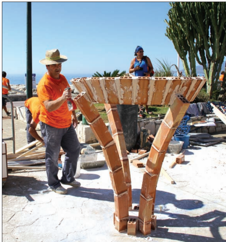
Trabajo de ejecución de la obra propuesta por la organización.
