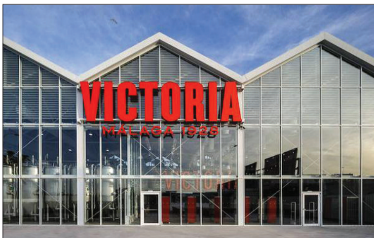
Fachada de la fábrica.
