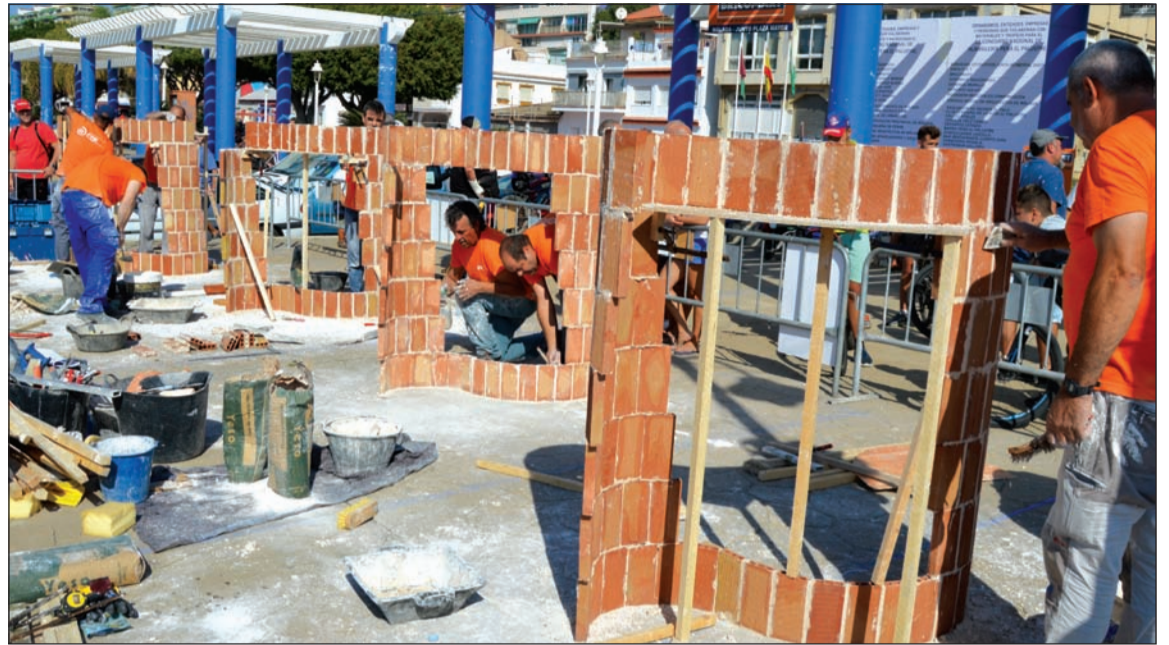
Cuadrillas durante el desarrollo de los trabajos.
