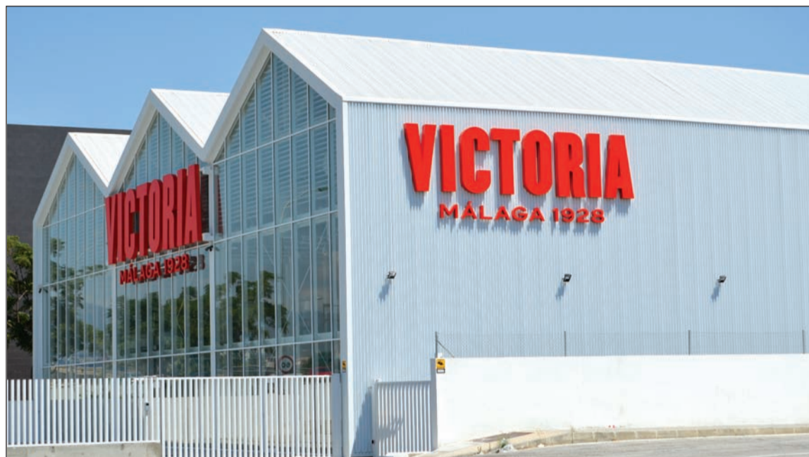
Aspecto de las nuevas instalaciones a pocos días de su apertura.
