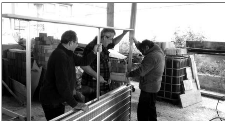
Trabajos en el interior de la sede.
